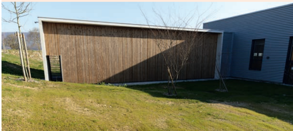
► À l'arrière de la chaufferie, un des nombreux regards donnant accès aux circuits d'eau qui alimentent les trente-trois sondes verticales.
