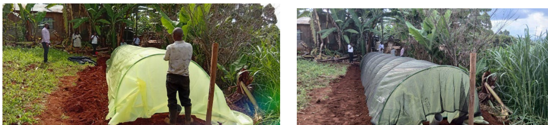
Installation de la serre et de la protection solaire
