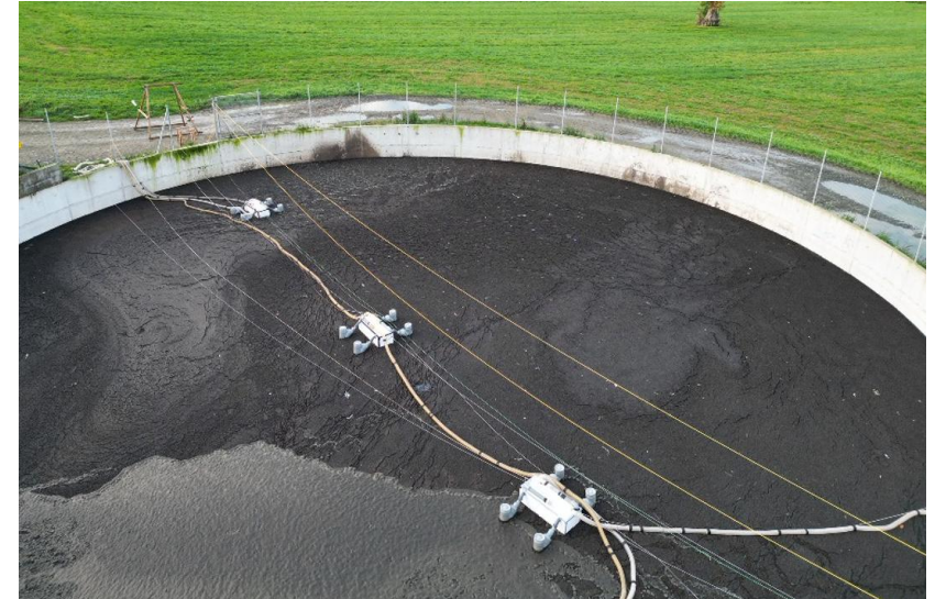
Mesures sur site
