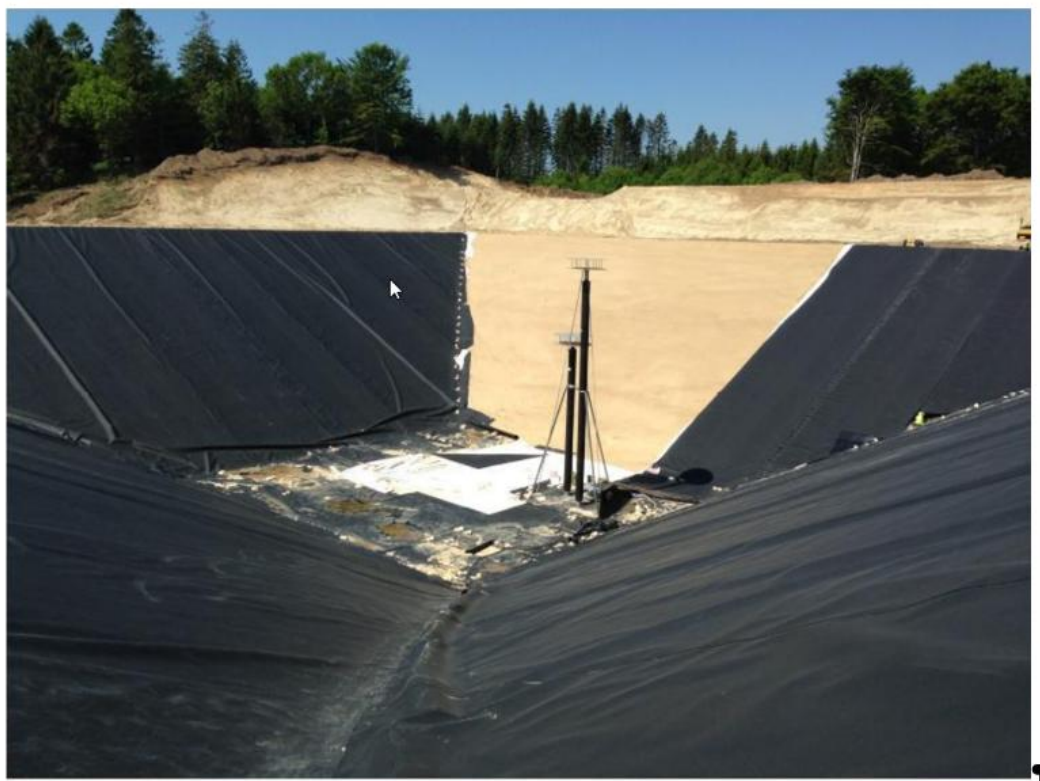
Figure 5. Le PTES de Dronninglund en construction. (Source : Dronninglund Fjernvarme)
