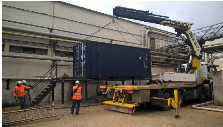
Acheminement du local technique préfabriqué
