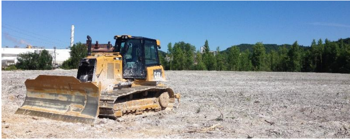
Reprofilage de l'ancienne zone de stockage de boues papetières
