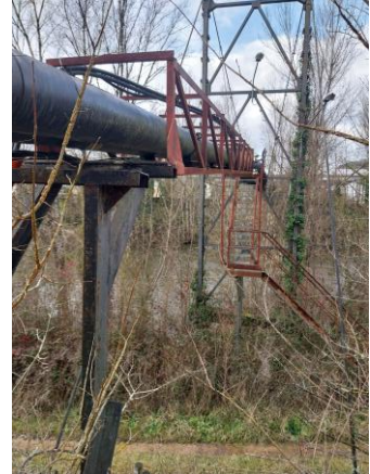
Passage de la tuyauterie sur une passerelle au dessus de la Vézère
