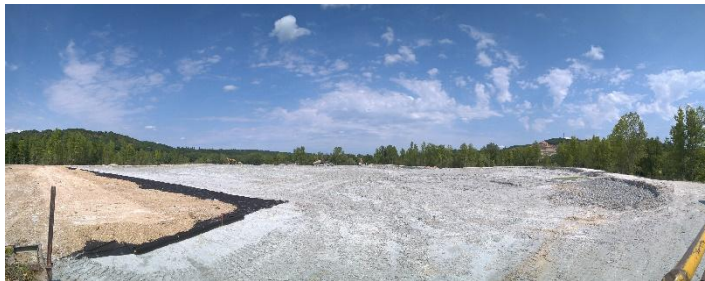
Mise en place d'une membrane semi-étanche
