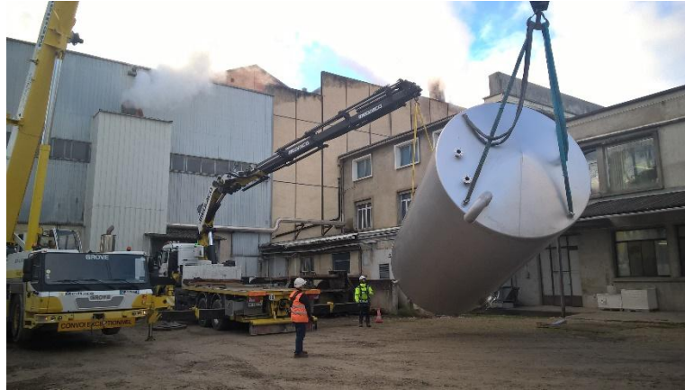
Installation de la cuve de stockage permettant de découpler production solaire et consommation de chaleur
