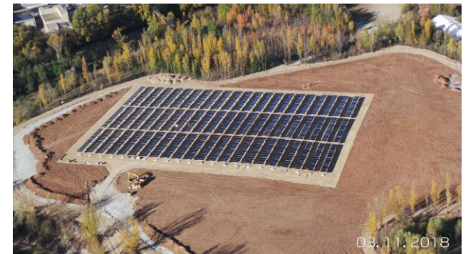
Champ de capteur en phase chantier
