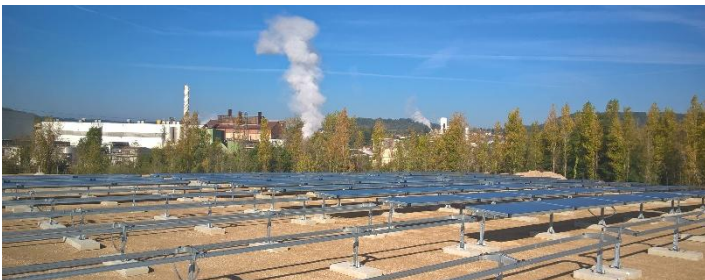
Installation des supports, des systèmes de suivi du soleil et des premiers capteurs
