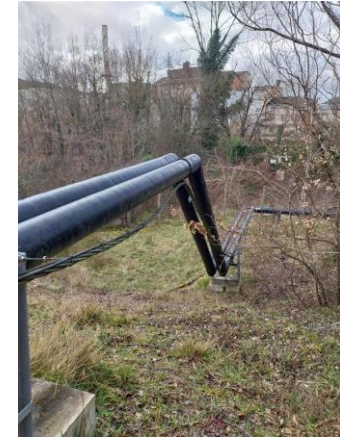
Passage de la tuyauterie sur une passerelle au dessus de la Vézère
