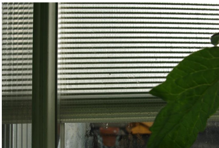
Figure 10 : Ecran thermique de paroi (source CTIFL ©)
