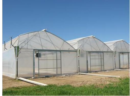
Figure 2 : Serre multichapelle plastique (CTIFL©)
