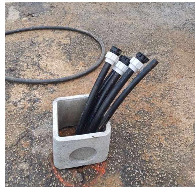
Sonde géothermique 200 m
