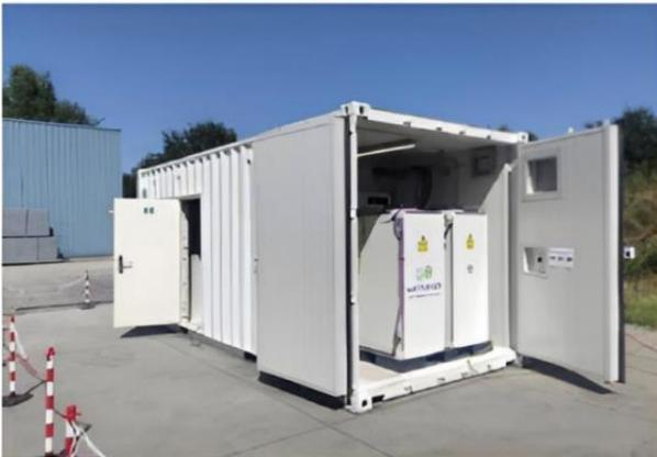
Conteneur de 1 MWh avec batteries de seconde vie issues de véhicules électriques
