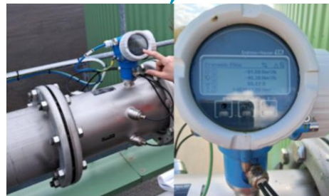
Installation débitmètres gaz
