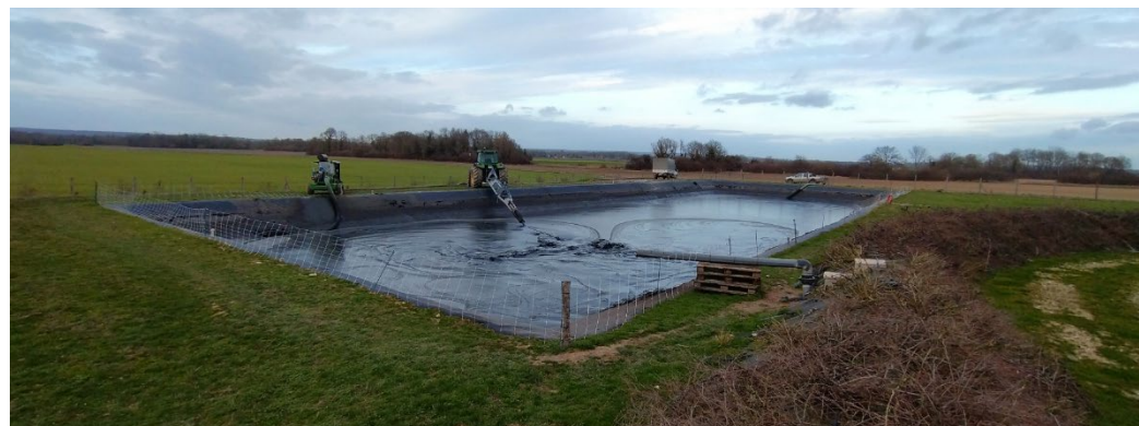
Lagune de stockage au cours d'un chantier d'épandage (brassage en cours)
