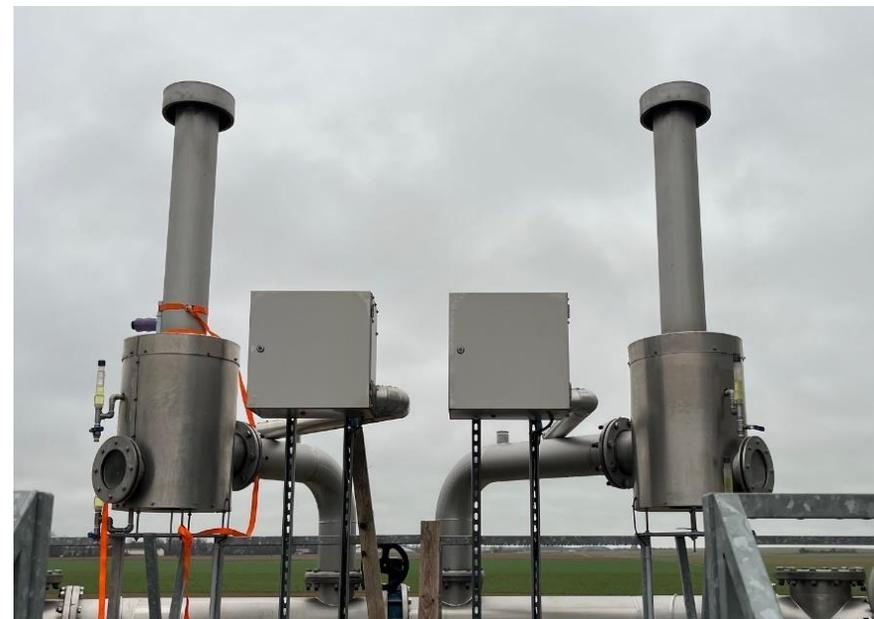
Figure 1: Soupape hydraulique sur une unité de méthanisation
