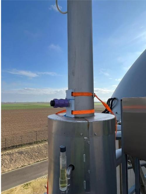
Capteur acoustique installé sur la cheminée d'évacuation
