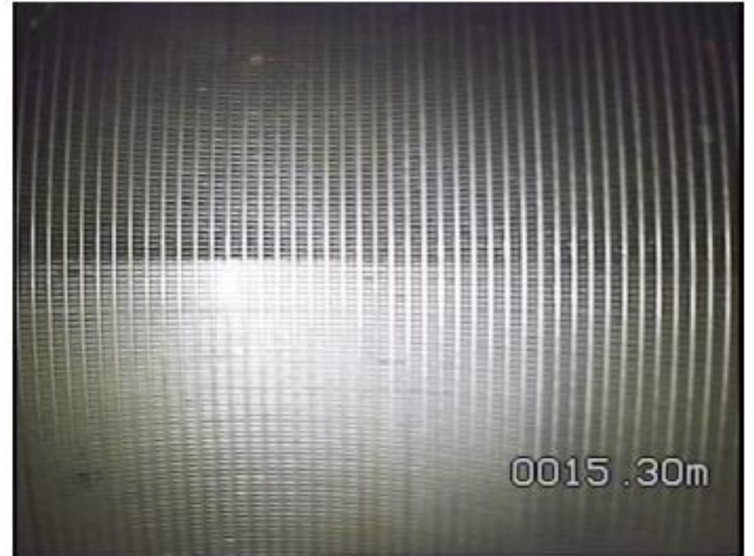
Vue sur la limite supérieure de la première tôle d'obstruction
