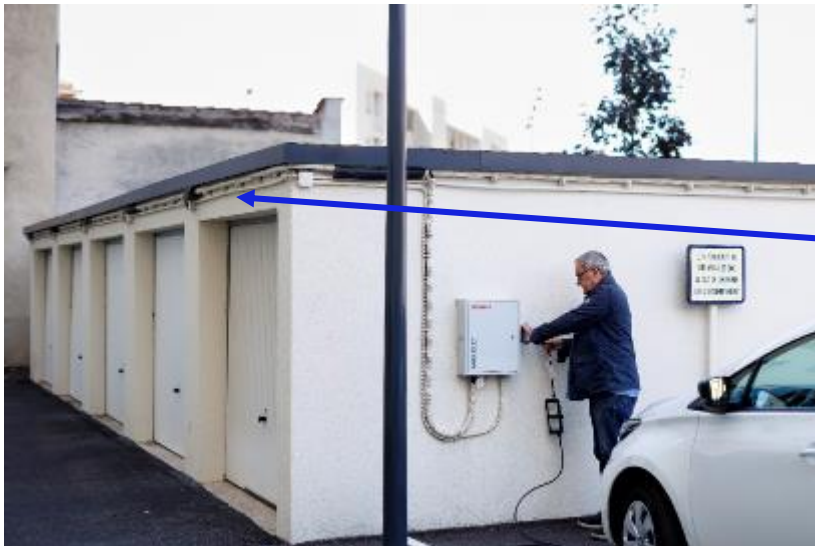
Pose du réseau sur façade pour box et mur
