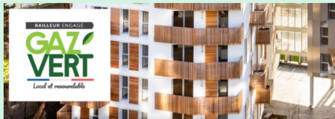
Logement social engagé gaz vert
