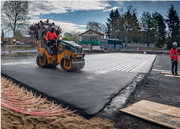
Des tubes sous la couche de roulement
