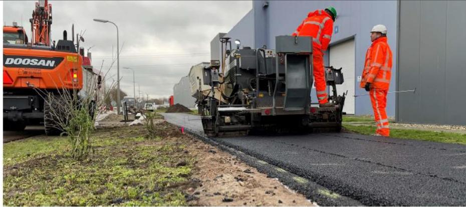
**Qu'est-ce qu'Ecofalt ?** Ecofalt est un nouveau produit pour la fabrication de chaussées, une alternative à l'asphalte. Ecofalt est produit à froid. Il en résulte une réduction de CO<sub>2</sub> pendant la production. La couche intermédiaire est faite de 100% matériau secondaire (asphalte).
