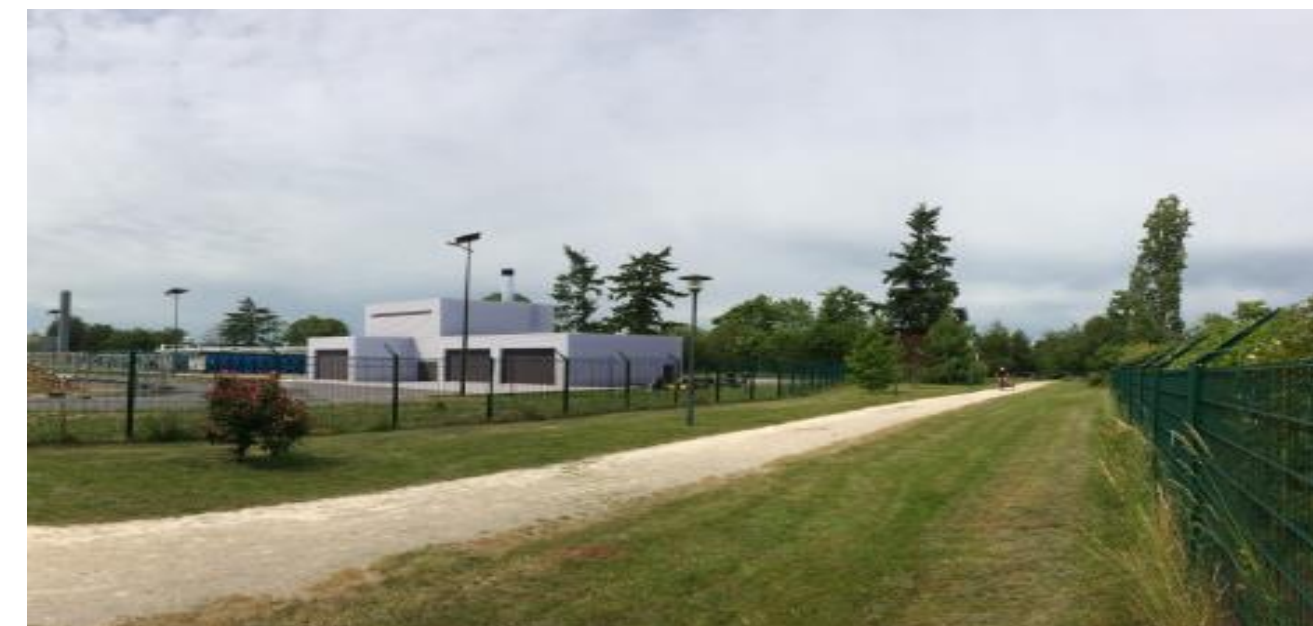
Silos Echelles racleuses enterrées
