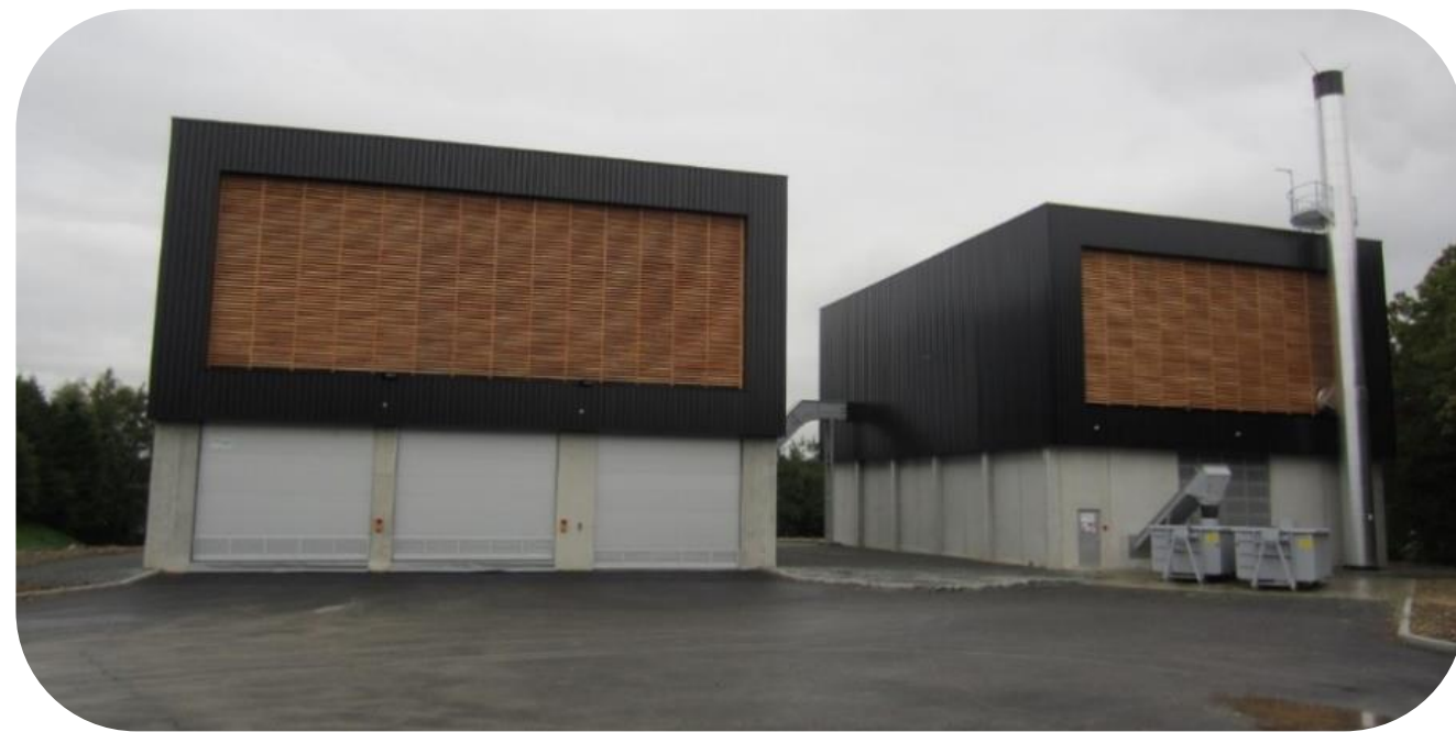
Silos Enterrés avec pont Grappin + échelle racleuse
