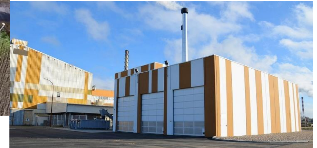
Silos Echelles racleuses carrossables
