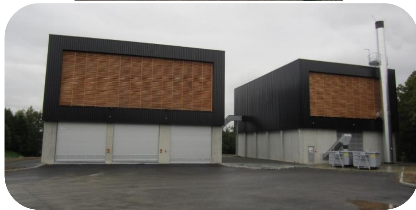
Silos Enterrés avec pont Grappin + échelle racleuse
