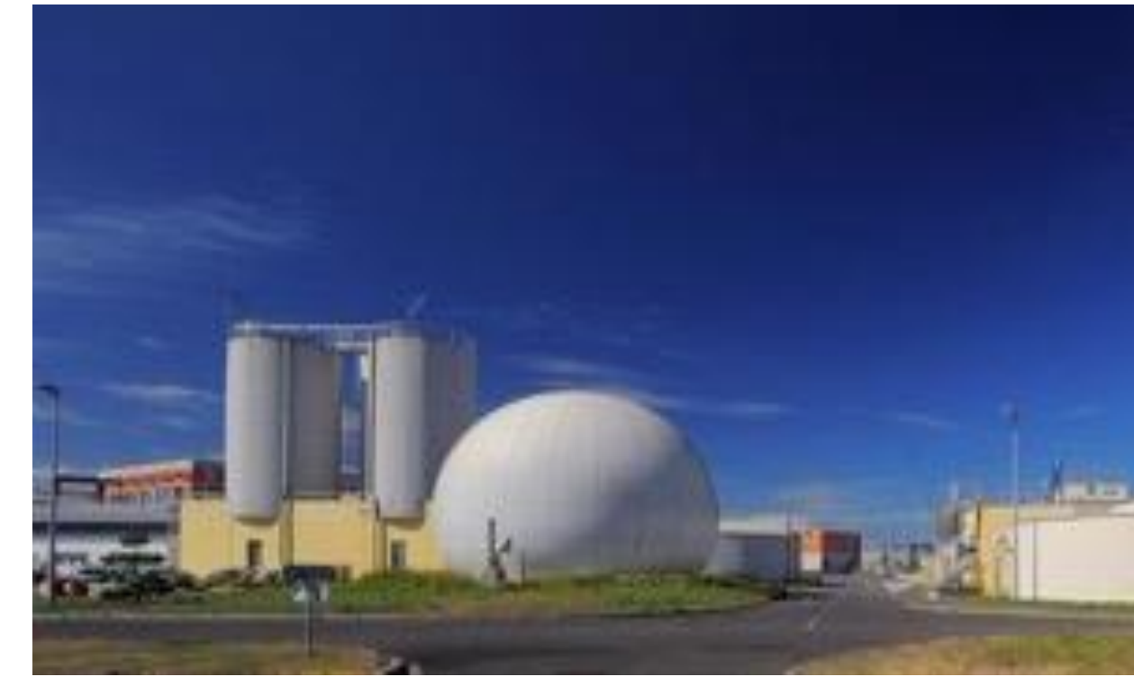
« Méthanisation de Boues de STEP »
