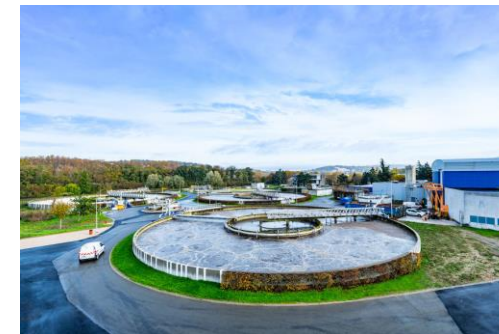
Gazéification hydrothermale : le méthane par traitement aqueux à haute température
