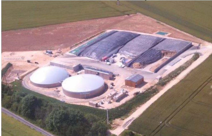
Figure 1 : L'installations de la SAS Valois Energie à Senlis (fin de construction en 2017)
