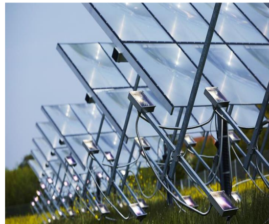
Fig.1b Vue d'un champ solaire utilisant la technologie HELIAC
