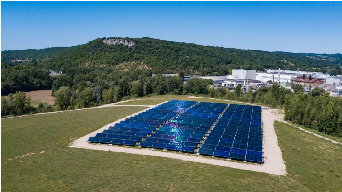
Fig.1 Centrale solaire thermique alimentant la papèterie de Condat du groupe LECTA (crédit photo NEWHEAT)
