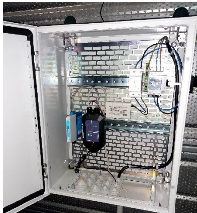
Mesure consommation gaz chaufferie Capteur Tyntess sortie impulsion avec barrière intrinsèque atex
