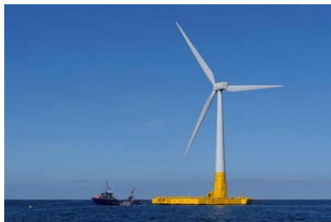
Technologies avancées pour les systèmes énergétiques
