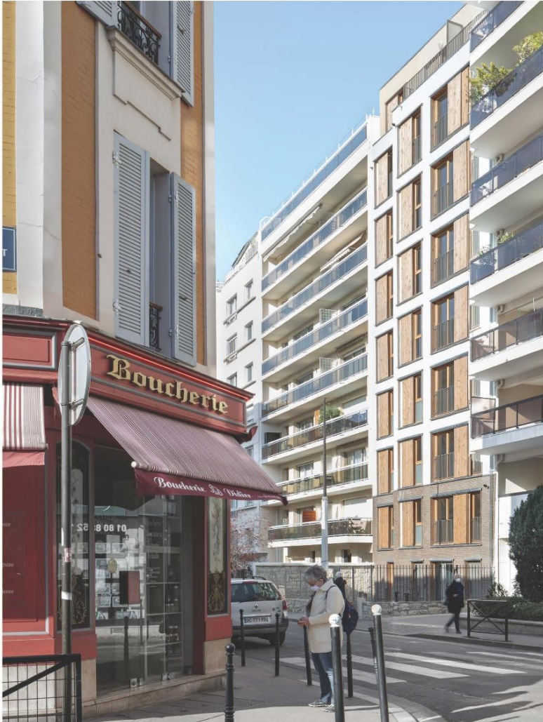
Construction de 15 logements, Rue de Bellevue, Boulogne-Billancourt (92) Murs refends béton + façades bois + remplissage en béton de chanvre
