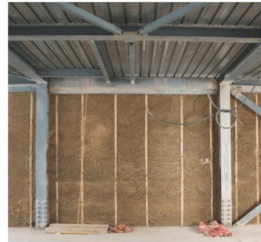
Construction de 4 logements en bois/métal/béton de chanvre Rue Myrha, Paris (18 ème )
