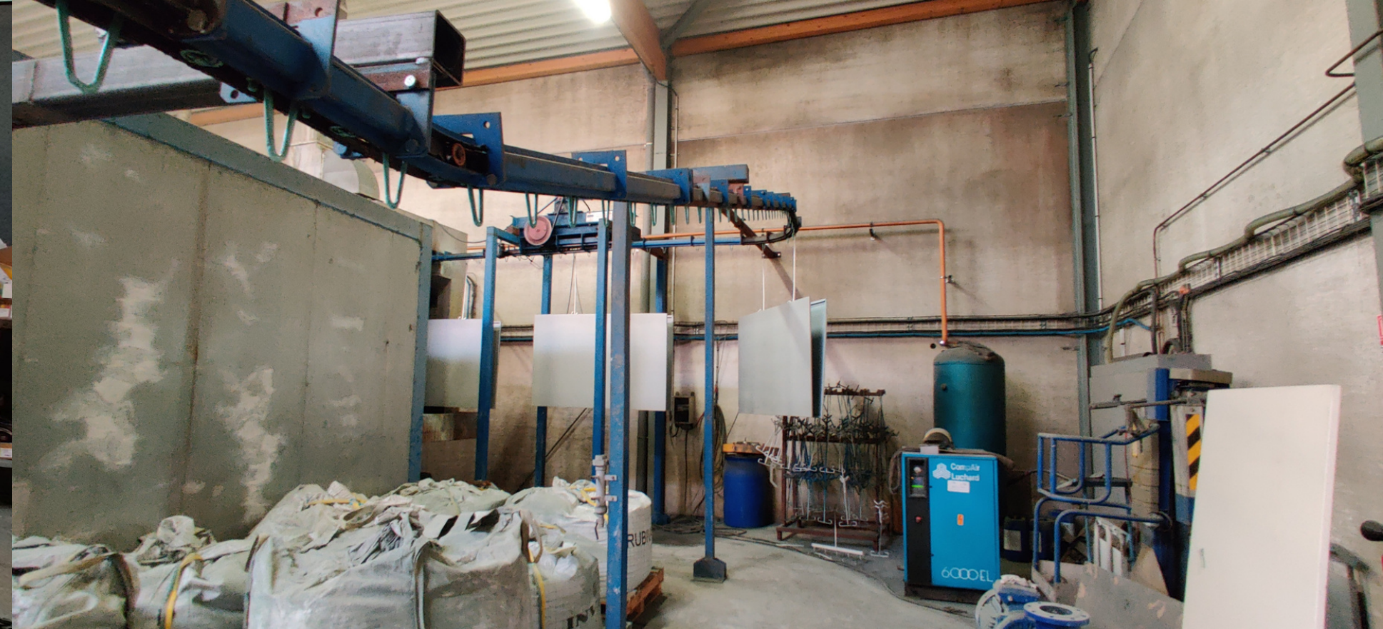
2 Rails pour aller vers le lavage
