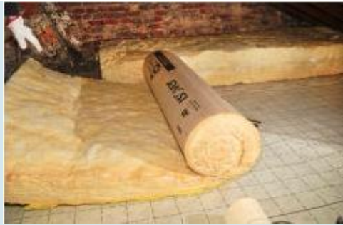
Isolation de comble perdu par rouleau
