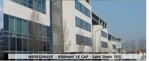
WERELDHAVE - Bâtiment LE CAP - Saint Denis (93)
