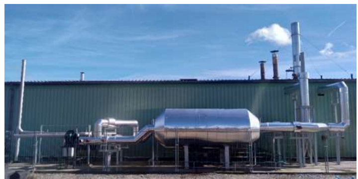
La solution Eco-Stock ® à l'extérieur de l'usine
