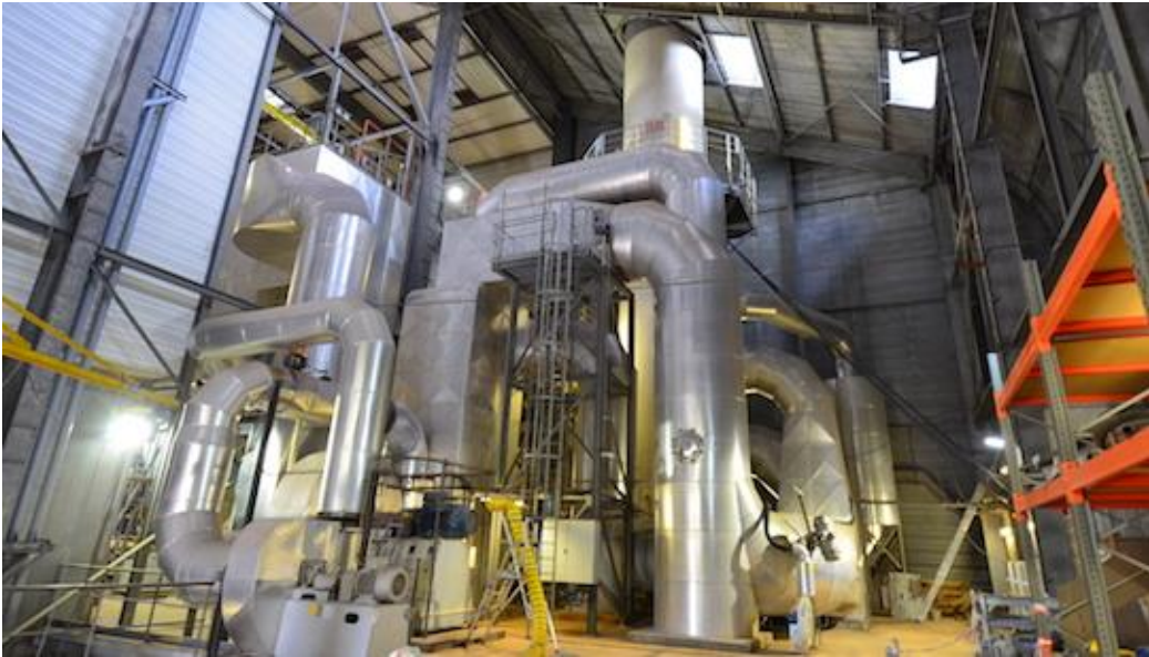
Extraction des fumées
