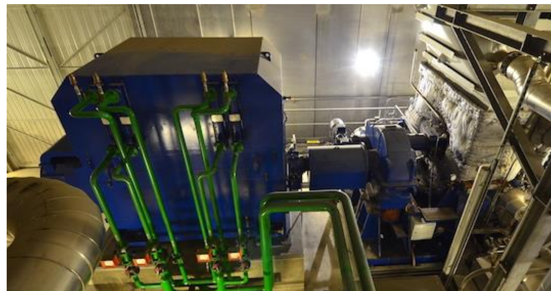
Groupe Turbo-alternateur 7,5 MW élec
