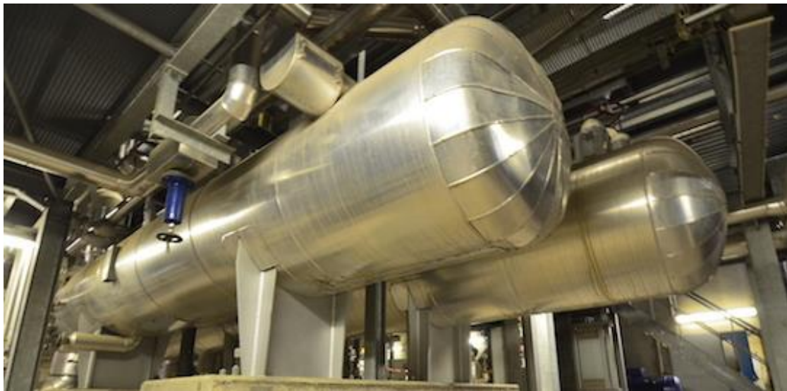
Hydrocondenseurs Vapeur/eau chaude 18 MW thermique
