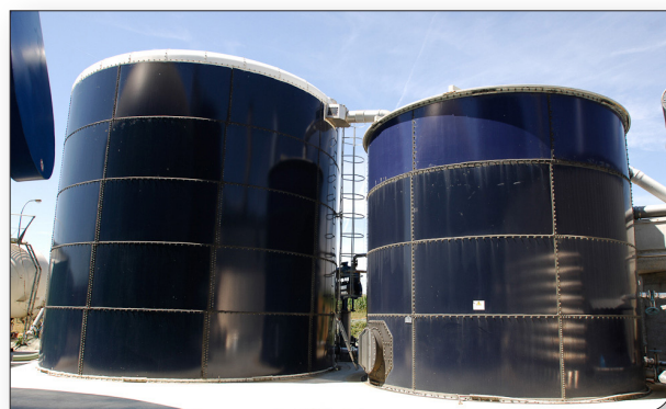
Méthanisation - étape de pré-traitement
