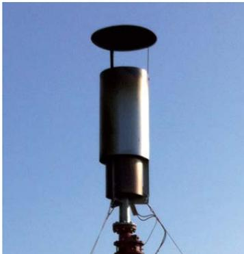
Permet de brûler le biogaz en cas de panne des dispositifs de valorisation du biogaz (moteur de cogé) → préférer une torchère automatique
