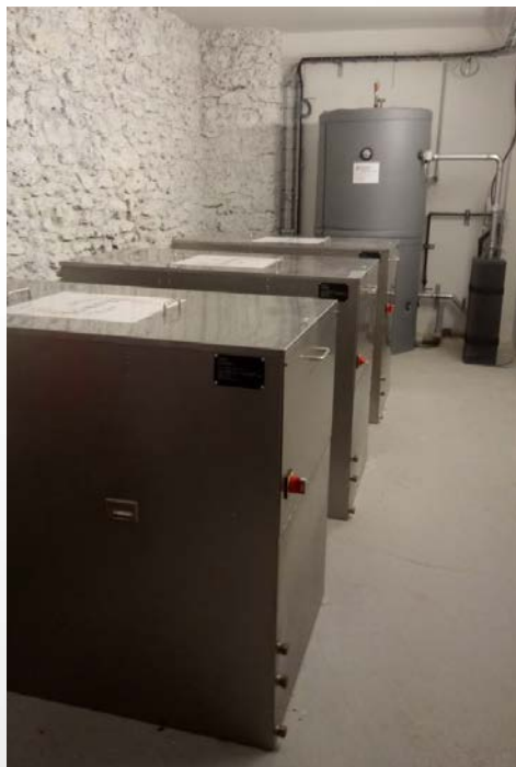
Local technique et chaudière numérique
