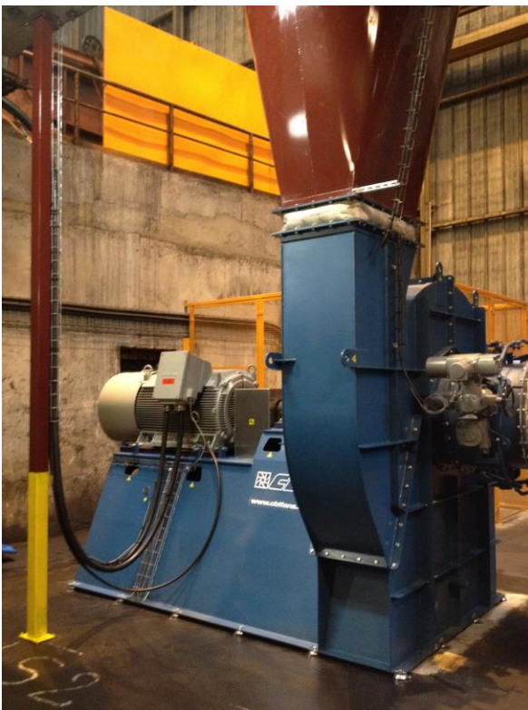
Figure 3 : Moto-ventilateur - Source : Vallourec
