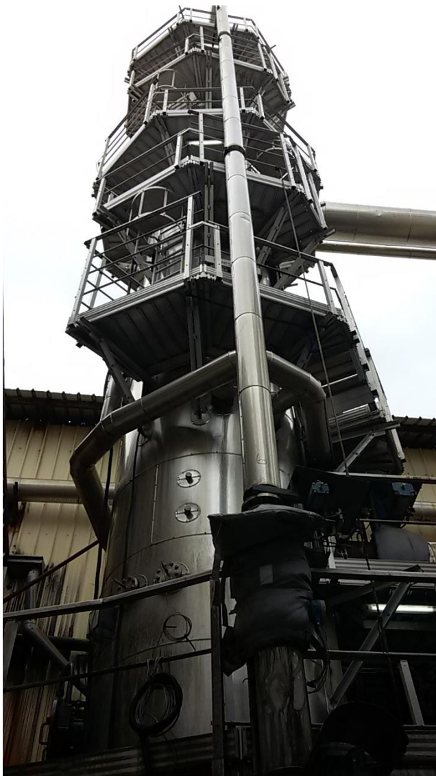
Figure 3 : corps d'évaporation à flots tombants (CEFT)
