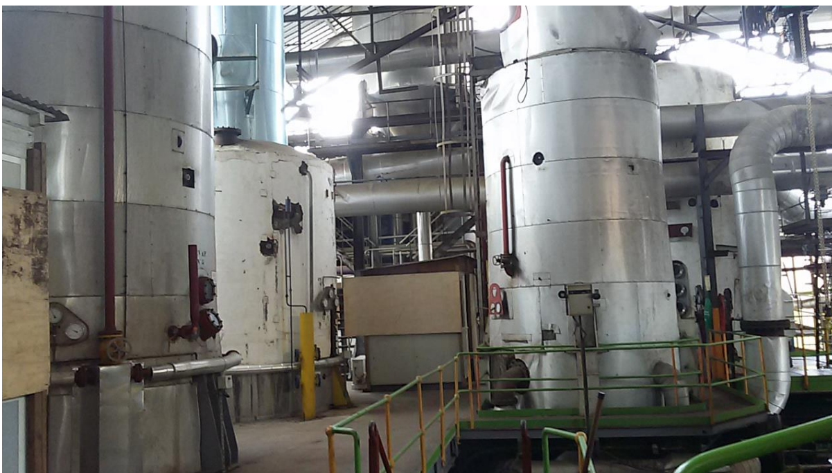
Figure 6 : caisses d'évaporation avant l'installation du CEFT
