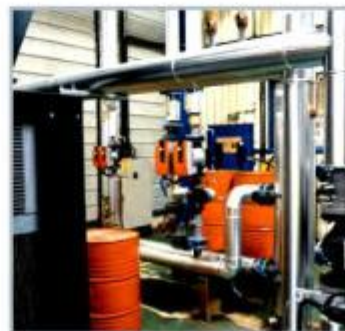
Le circuit de récupération de calories est réparti entre le chauffage et l'eau sanitaire.
