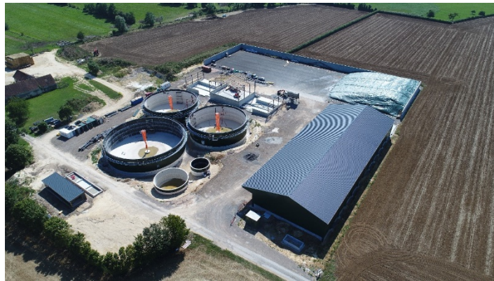
Figure 2 : Vue de l'installations de la SAS Beaulieu MÉTHANERGIE, à Argentan côté digesteurs et en cours de construction au mois de mai/septembre dernier.
