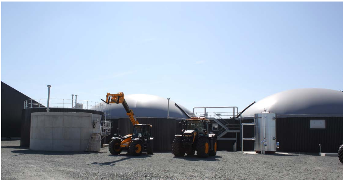
Figure 1 : Vue d'ensemble de l'installation de méthanisation (source ATEE)
