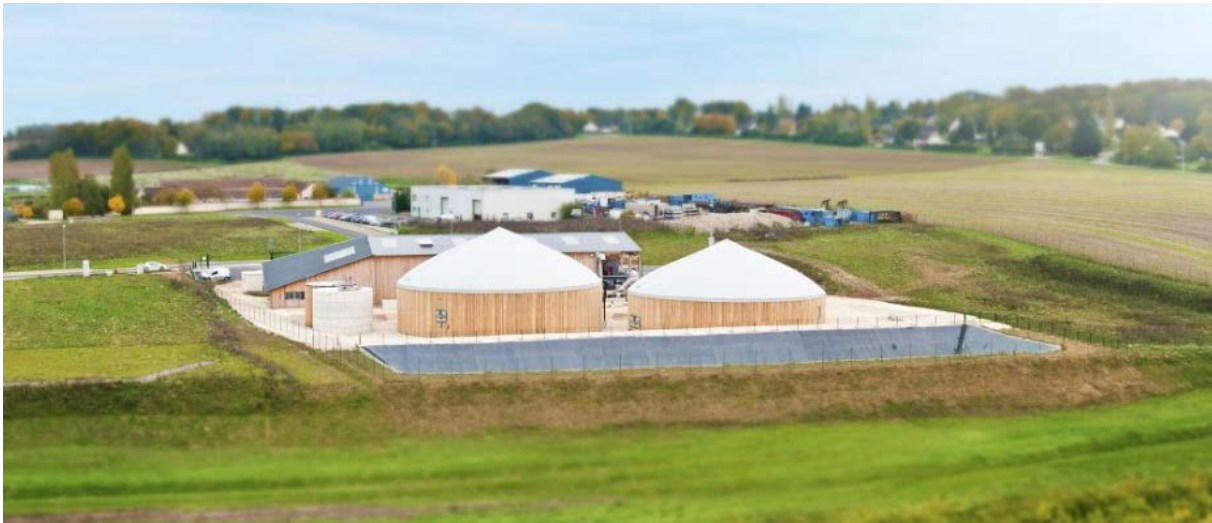
Figure 1 : Vue d'ensemble de l'installation de méthanisation (source Naskeo)
