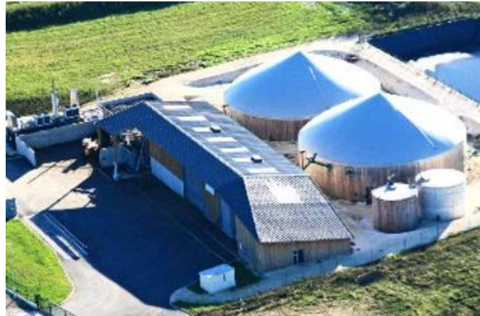
Figure 2 : Vue aérienne de l'installation de méthanisation (source Naskeo)
