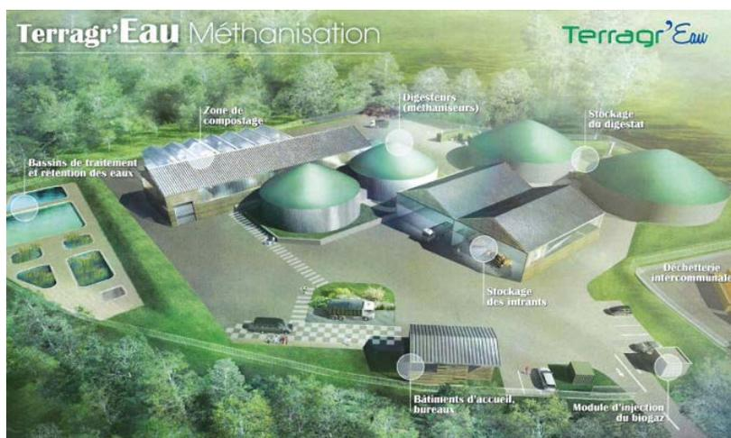
Figure 2 : schéma d'ensemble du site
