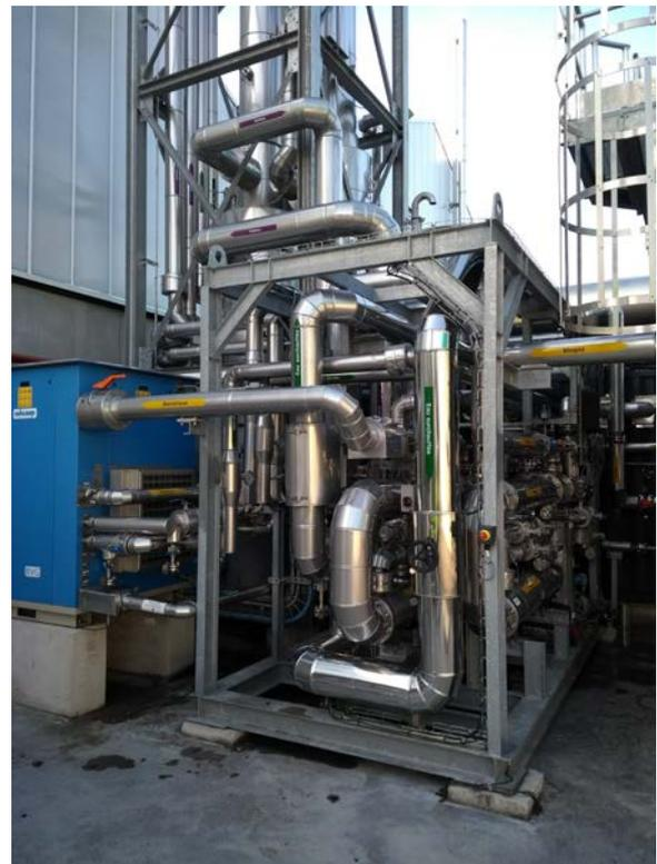
L'unité AE-Amine est la première unité d'épuration de biogaz utilisant la technologie de lavage aux amines en France. L'innovation repose à la fois sur un brevet Arol Energy pour l'intégration énergétique de l'unité de purification avec les digesteurs de méthanisation et sur un nouveau solvant mis en œuvre dans le cadre d'un partenariat avec IFP Energies
