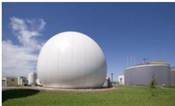
Figure 14: Gazomètre double membrane Source: Communauté d'agglomération
