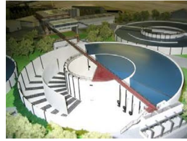
Figure 7: Coupe du bassin d'aération Source: Communauté d'agglomération
