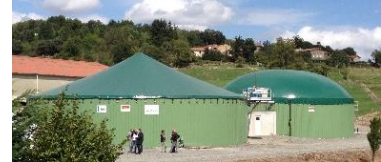
Crédits photo : Club Biogaz. Unité de méthanisation, SARL Robert Forez Energie et Evalor, Verrières-en-Forez
