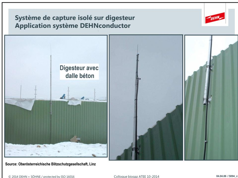
**Installation biogaz – Protection du digesteur
