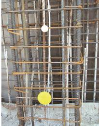
Raccordement du conducteur de descente à l'électrode de terre de fondation
