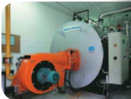
Système de mise en chauffe de l'appareil de production
