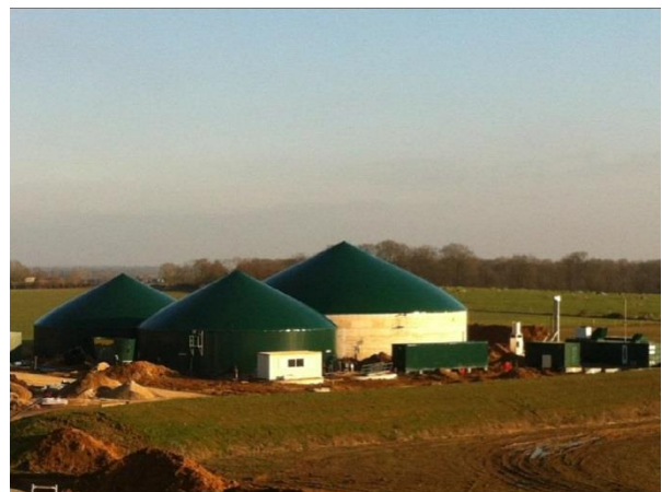
Figure 2 : digesteur, post-digesteur, stockage de digestat. Source : M.Quaak
