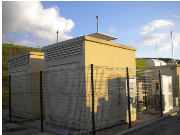
Compresseurs de biométhane, débits de 210 m 3 /h (Semardel, Vert-le-Grand)
