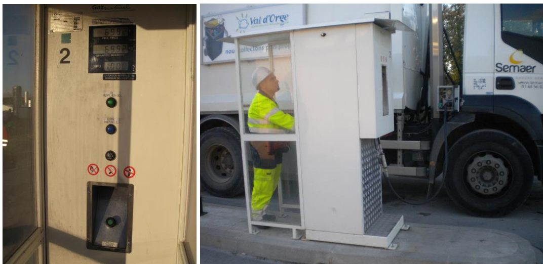
Installation de distribution rapide privée de GNV (Semardel, Vert le Grand)
