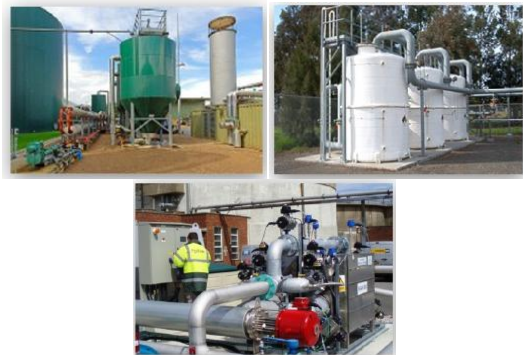
Figure 174 : Techniques d'élimination des siloxanes (En haut à gauche : Charbon actif – En haut à droite : Graphite activé – En bas : filtre à régénération PpTek) Source : PpTek
