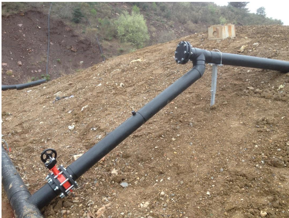
Figure 126 : Vue sur quelques aménagements de dégazage : collecteurs PEHD, vanne à volant, point de piquage, piquet réglable - source : CSD Ingénieurs
