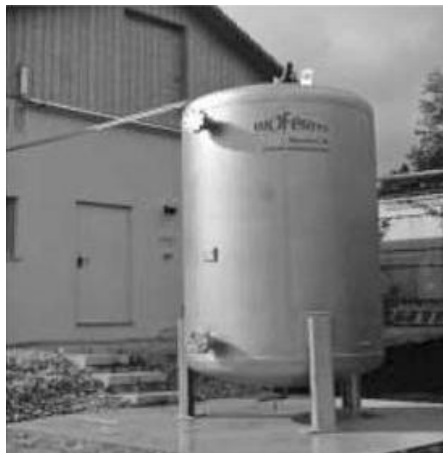
Figure 139 : Réservoir de stockage du biogaz en moyenne pression - Source : Sino-German Project
