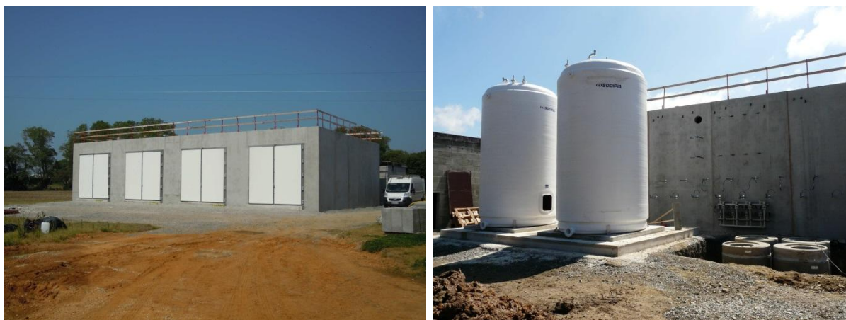
Figure 11 : Construction d'un méthaniseur en garage - A gauche : garages avec portes étanches A droite : équipements de gestion du percolat – Source : Methajade
