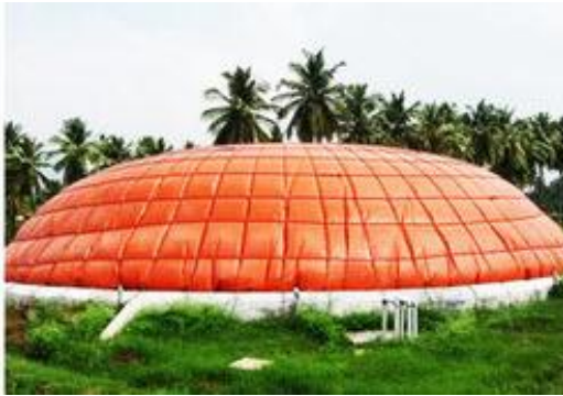
Figure 133 : Cas de l'installation d'un toit souple au-dessus du digesteur. A gauche membrane montée sur un digesteur - Source : Arjun Energy Corporation (Inde). A droite schéma du principe : Source Bio-ch4.com
