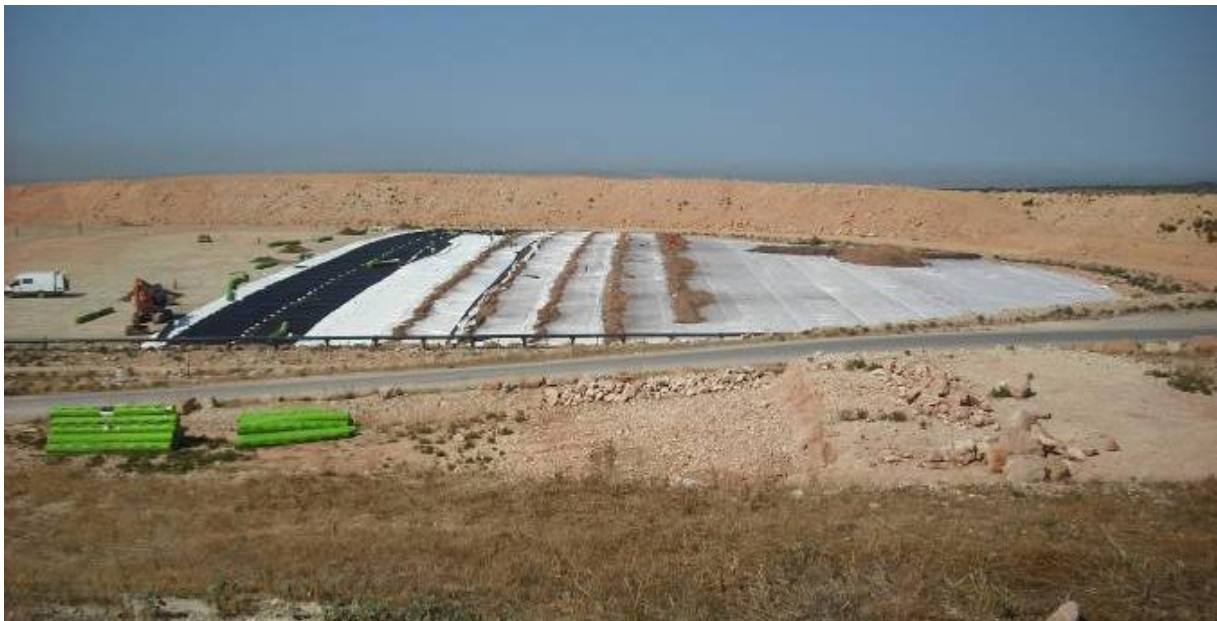
Figure 129 - Pose d'une couverture en géomembrane - source : CSD Ingénieurs
