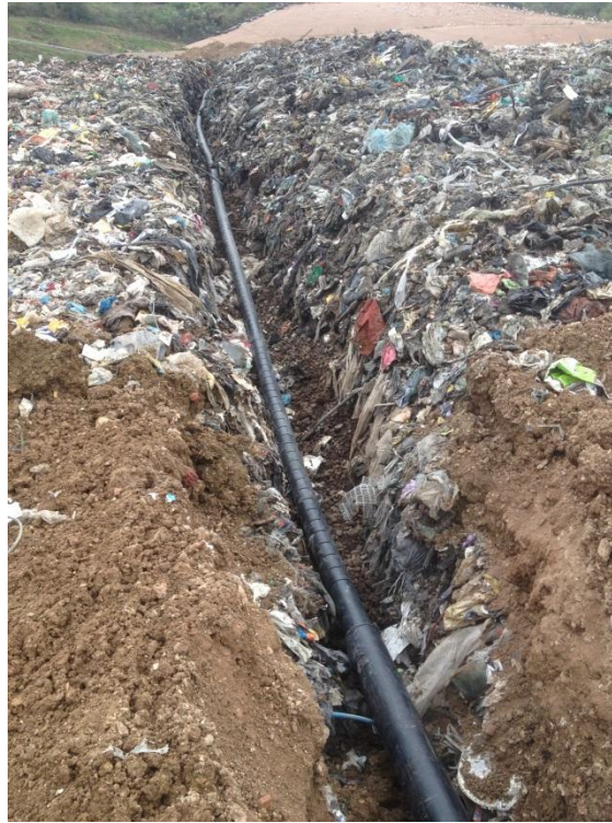
Figure 125 : Pose d'un drain de dégazage horizontal – Source : CSD Ingénieurs
