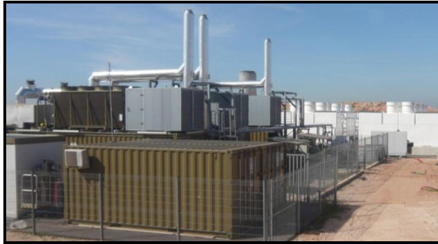
Figure 144 : Moteurs de cogénération fonctionnant au biogaz de décharge Source : AEROE
