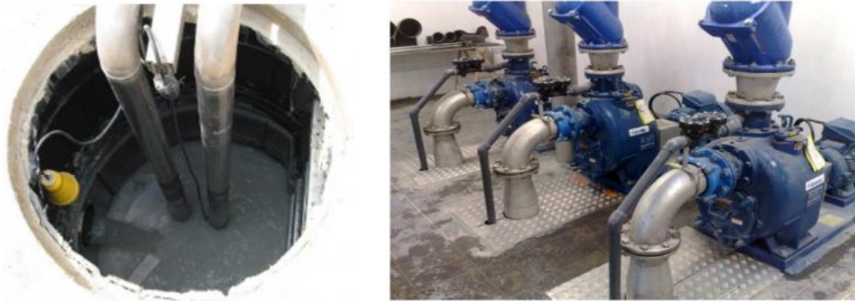
Figure 36 : Accessibilité des pompes immergées et de surface – Source : Hydro-group
