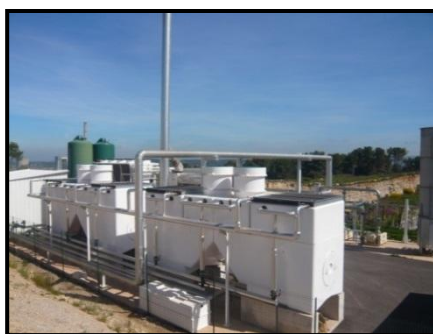
Figure 232: 2 modules DHC08+1 moteur cogénération fonctionnant au biogaz – Source : AEROE
