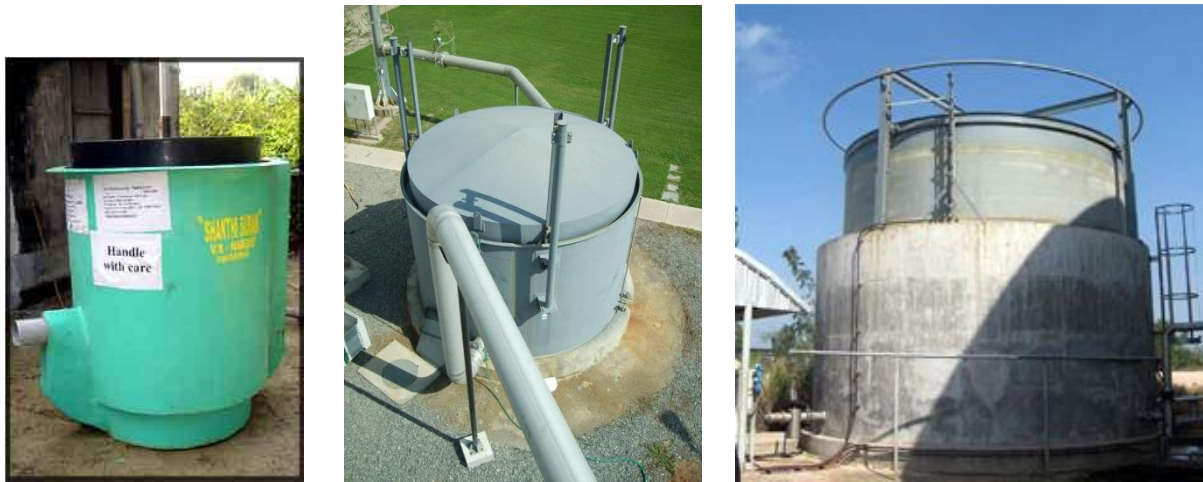
Figure 138 : Gazomètres cloche. De gauche à droite : en plastique, en acier, et en béton/acier Sources : A gauche, Tecnovias (Brésil) – Au centre, Bio-ch4.com - A droite, Distington (Inde) Pressurisé
