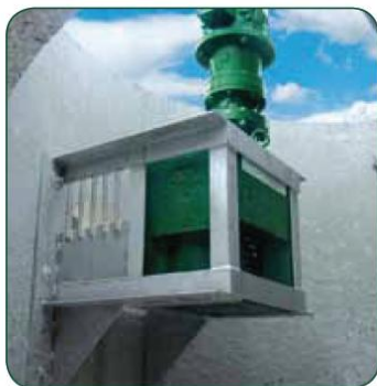
Figure 50 : Broyeur compact Mini Monster® installé dans une station de pompage Source : Hydro-Group
