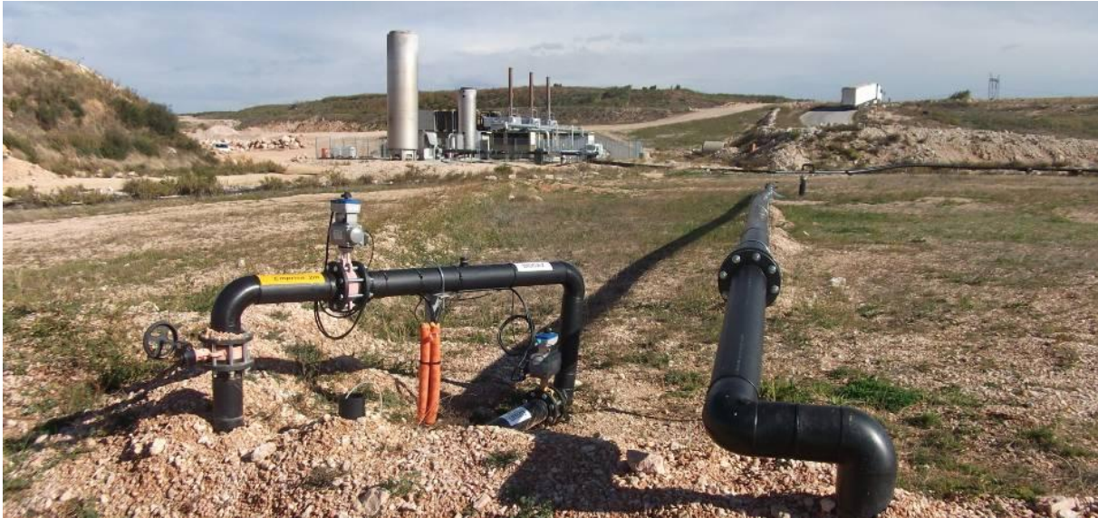
Figure 131 : Vue au premier plan sur réseaux de réinjection et de dégazage, et moteurs de valorisation au second plan - Source : CSD Ingénieurs
