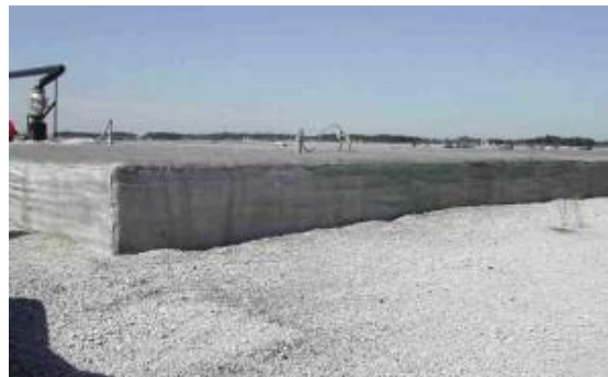
Figure 132 : Digesteur bétonné de type piston en U, permettant le stockage depuis la source Source : Wisconsin Manure Management (USA)
