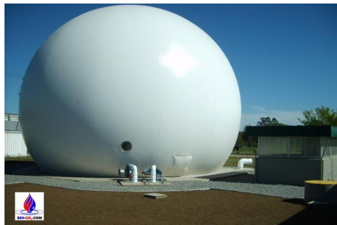
Figure 136 : Gazomètre double membranes souples de 780 m 3 , avec vue au centre sur les deux soufflantes à air, et le registre sur sa droite – Source : Bio-CH4.com
