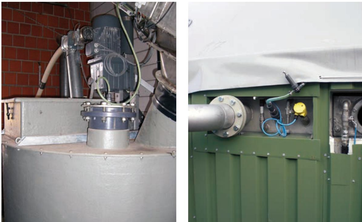
Figure 170 : Points de dosage de sels de fer possibles (A gauche : dans la cuve mélangeuse – A droite : directement dans le fermenteur) – Source : Kronos Ecochem
