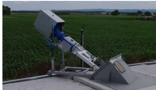
Figure 77 : Agitateur mécanique en traversée de paroi - Source : KSB
