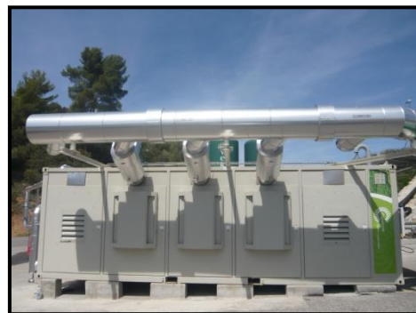
Figure 145 : microturbines fonctionnant au biogaz de décharge
