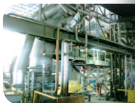
Système de séchage des tournures installé
