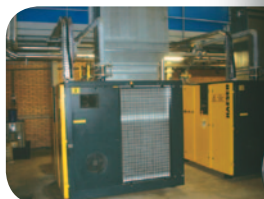
Compresseurs T/R de 90kW
