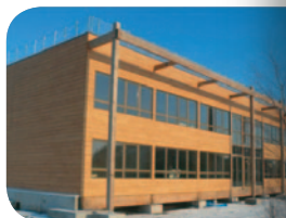
Vue externe du bâtiment
