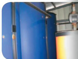
Réservoirs d'eau chaude
