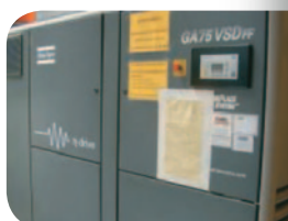
Nouveau compresseur à vis à vitesse variable
