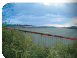
Panneaux solaires de production d'eau chaude
