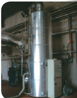
Nouveau système de production d'eau chaude
