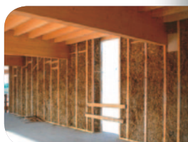
Vue interne du bâtiment
