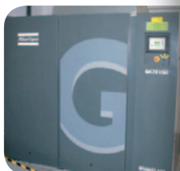
Compresseur à VEV
