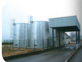
Unité de Méthanisation des effluents de la fromagerie
