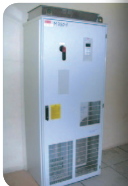
Variateur Electronique de Vitesse mis en place
