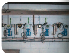
Compteurs eau et vapeur mis en place
