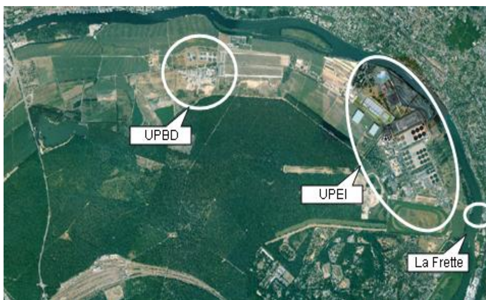
Figure 1 : Vue aérienne actuelle du site – source SIAAP
