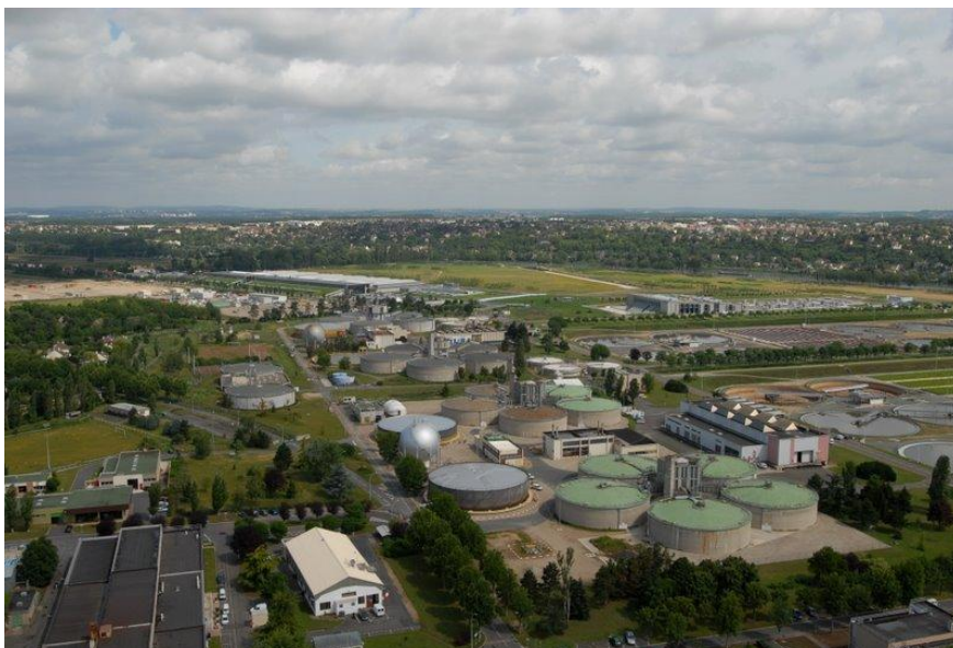
Figure 7 : vue aérienne de la digestion – source SIAAP
