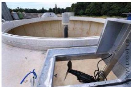
Figure 3 : L'agitateur du post-digesteur (en arrière plan) - source AILE
